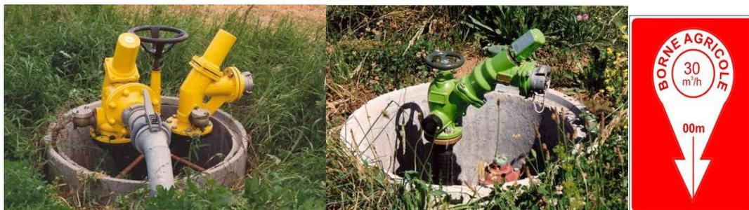
Les **PENA** qui ne seraient pas équipés d'un poteau d'aspiration bleu mais dotés d'un autre dispositif fixe d'aspiration (colonne, guichet, ...) devront recevoir, au niveau de la prise, une **couleur bleue** (référence RAL 5015 ou RAL 5012) permettant le repérage rapide de cette dernière.
